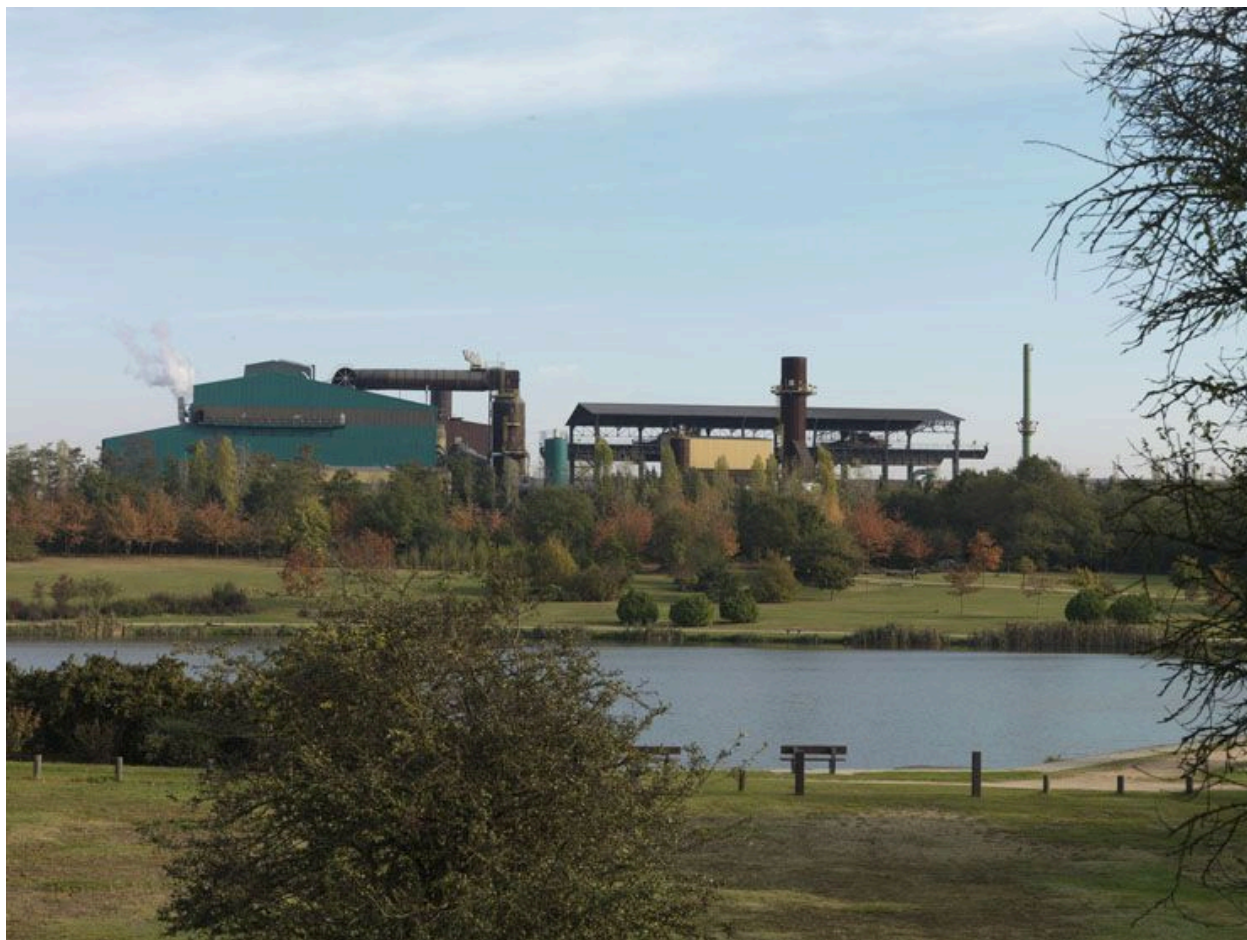
Porcheville : parc de loisirs au lieu-dit Les Pommiers ronds, le long de la D 146.
