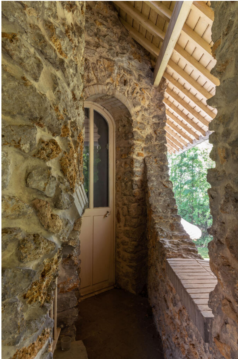
Recoin de balcon en façade sud.
