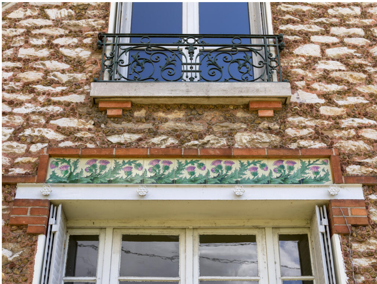
Détail de la façade du 25 rue Saint-Pierre.
