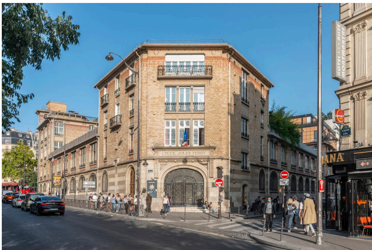
Vue générale du lycée et de son entrée.
