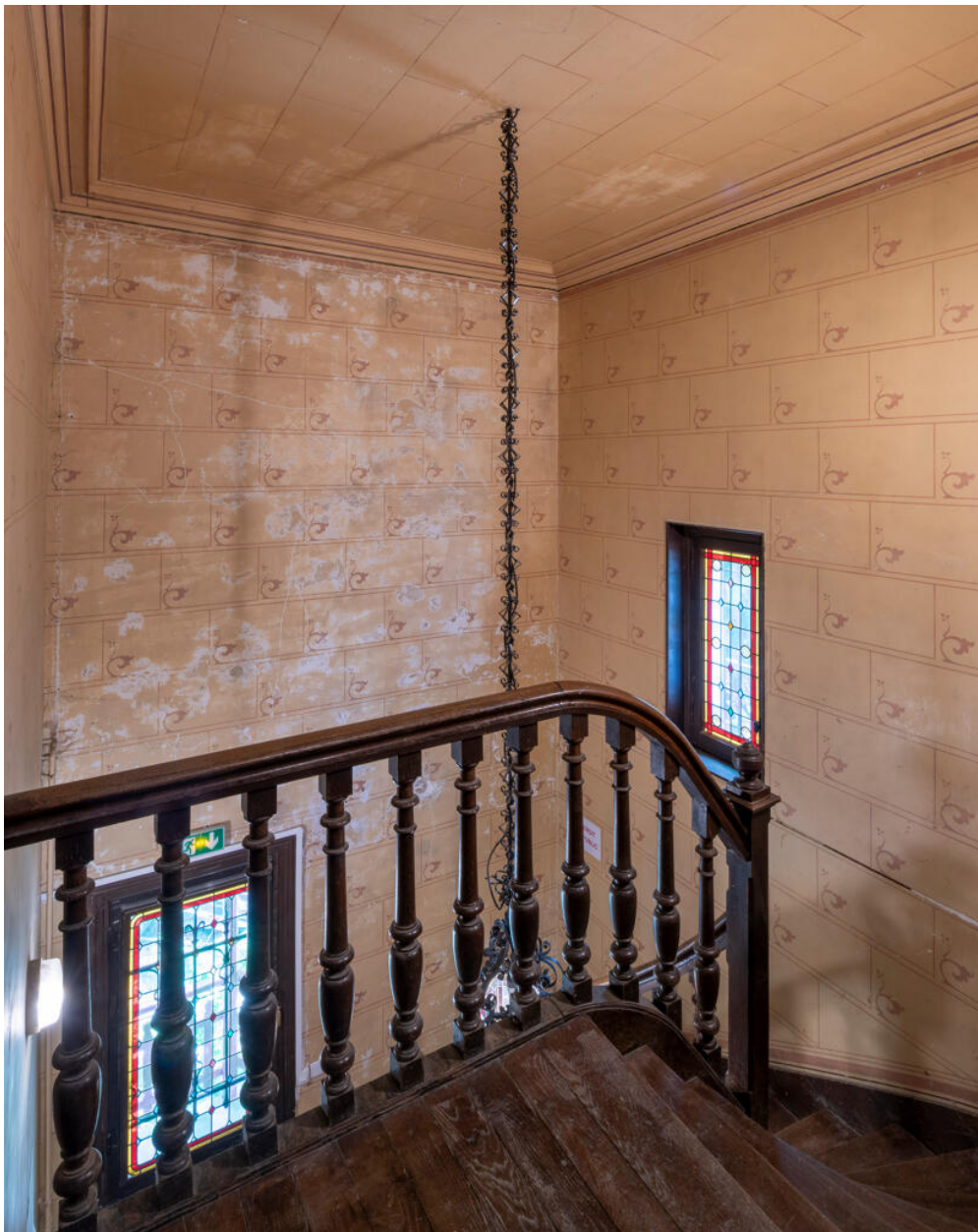
Palier de l'escalier
