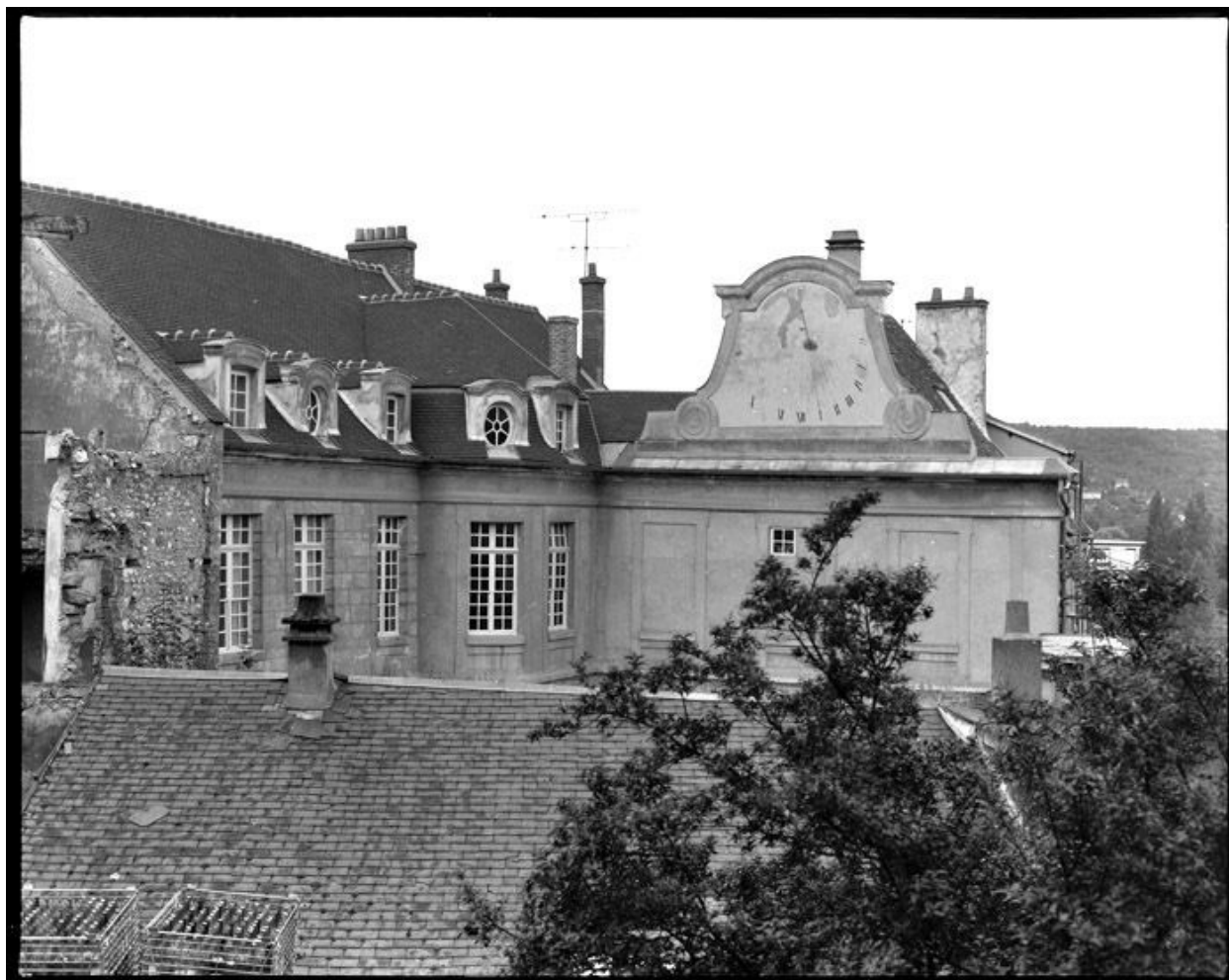
La façade sur cour en 1977.
