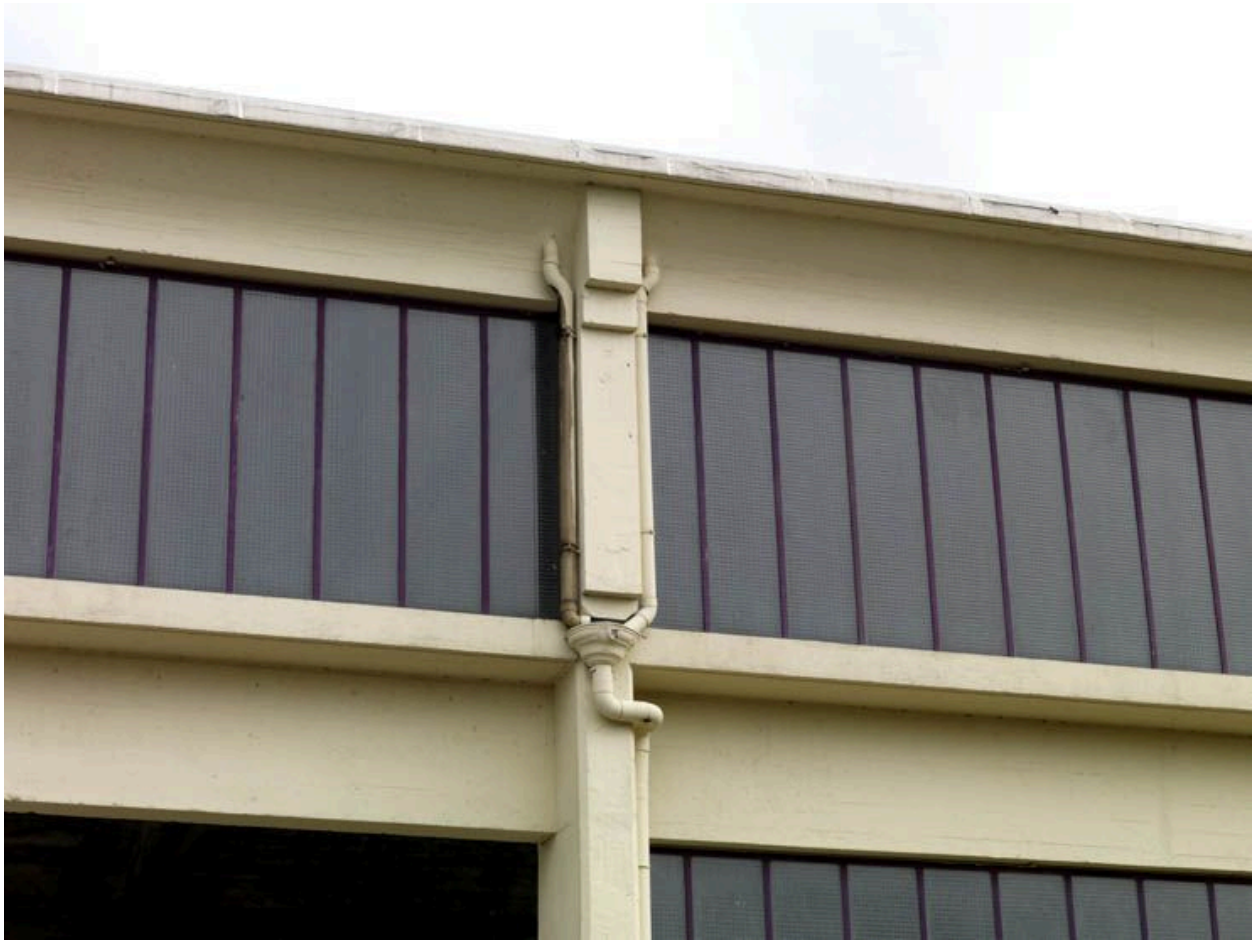
Halle en béton ayant abrité le banc de sciage. Vue de détail du système de gouttière.
