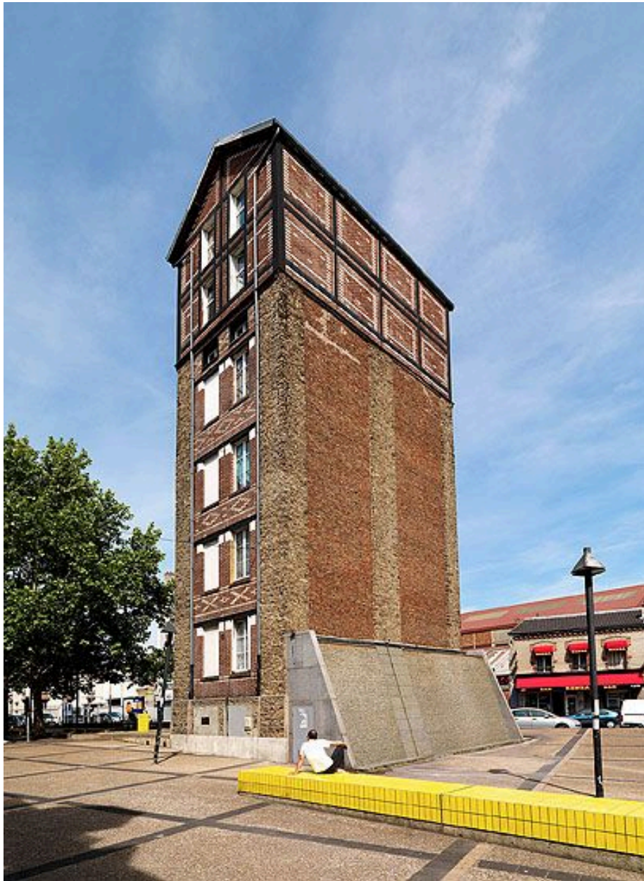
93, Courneuve (La), château d'eau, boulevard Pasteur. Vue de l'ensemble.
