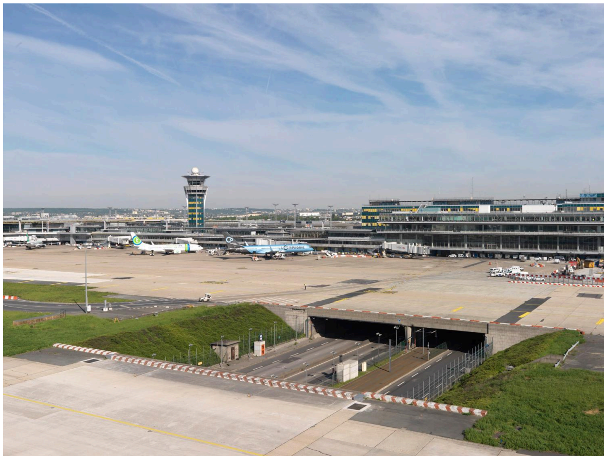
2018, Orly-Sud depuis la tour du poste de contrôle et répartition (PCR), vue prise depuis le sud.
