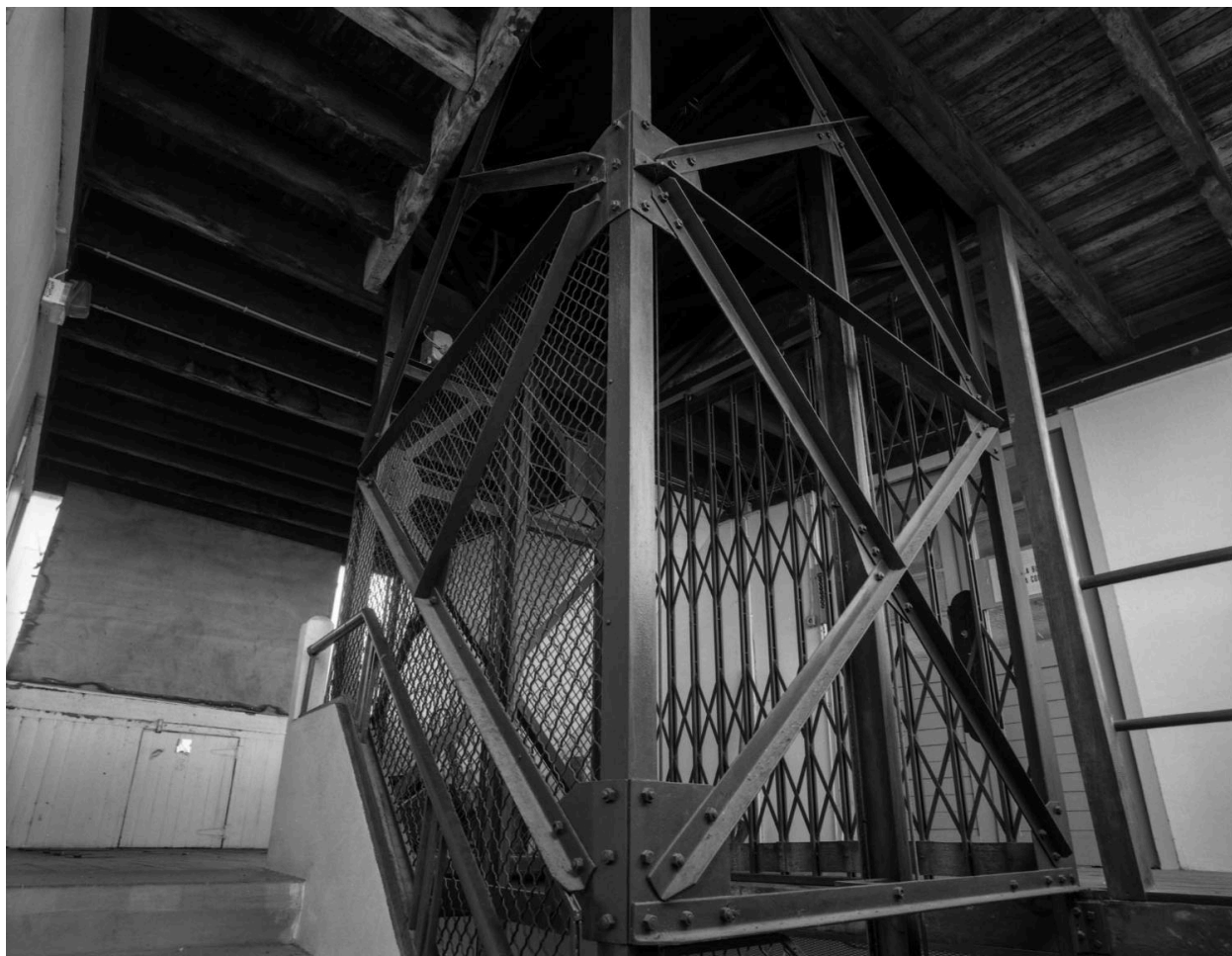
Bâtiment principal, cage du monte charge.
