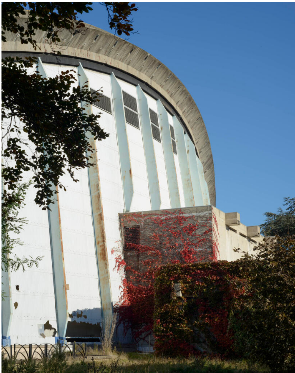
Grande Nef Lucien Belloni, dite Grande Nef de l'Île-des-Vannes. Détail de l'élévation principale.
