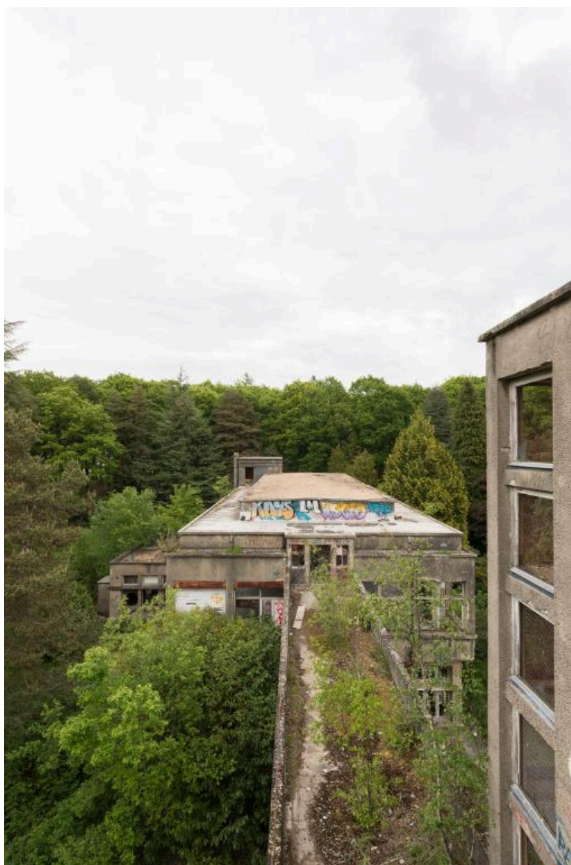
pavillon Bonnefoy-Sibour, vue du toit-terrasse vers l'est
