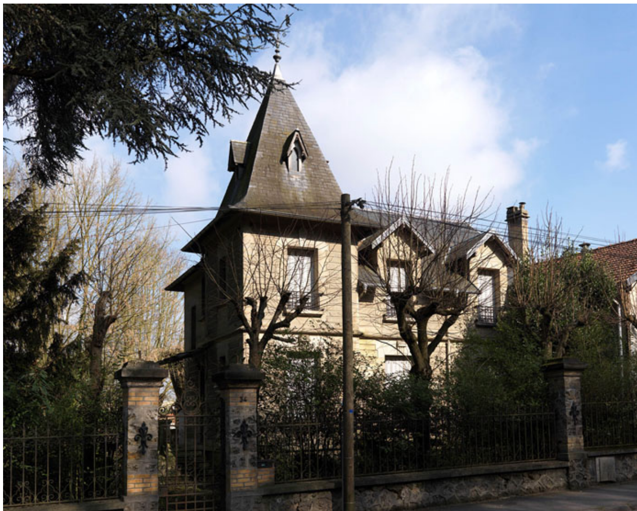
Le logement du maître d'hôtel et du jardinier, aujourd'hui maison particulière, 34 rue de la Libération : vue d'ensemble, depuis le sud-ouest.
