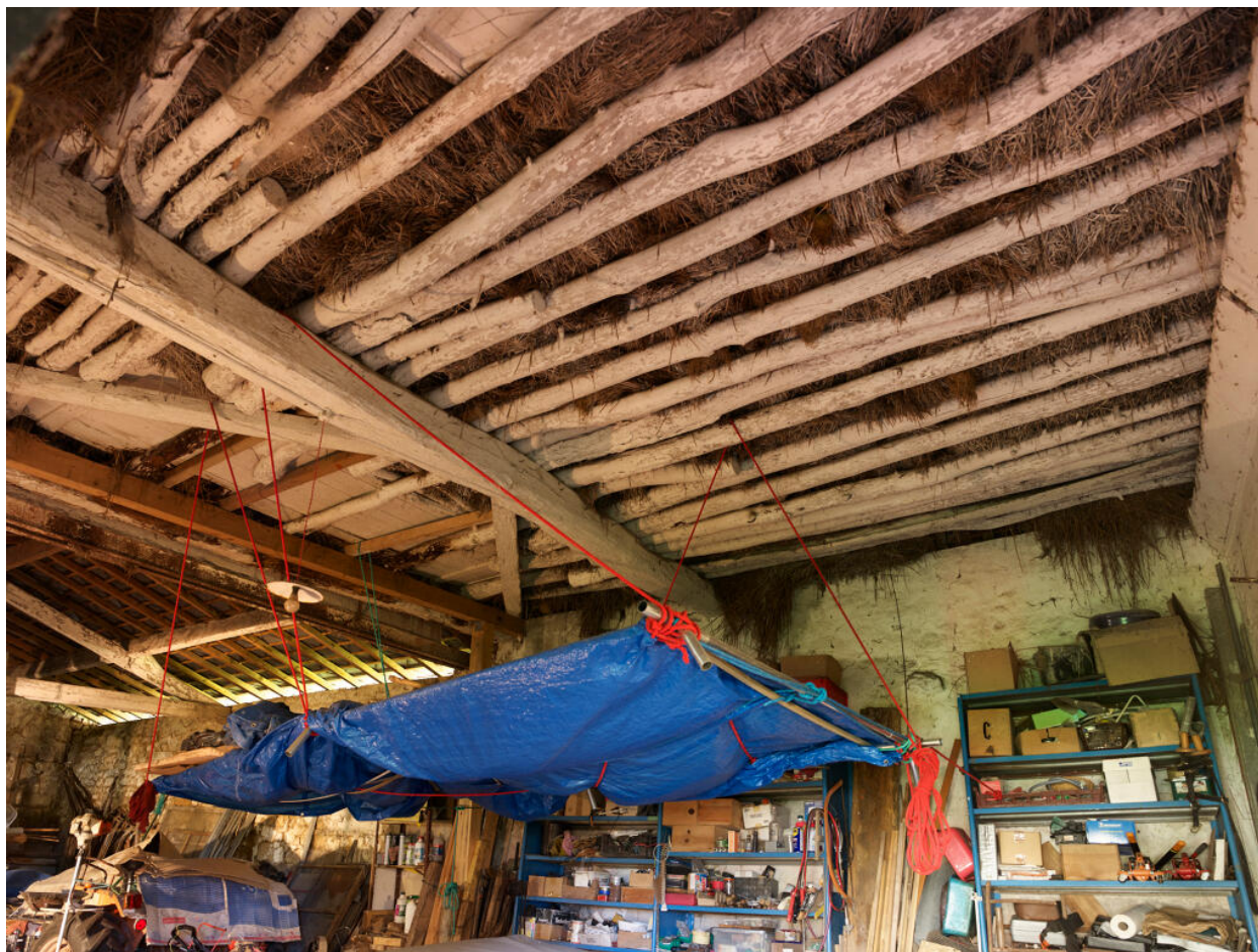
Détail du plancher haut du rez-de-chaussée de la dépendance.
