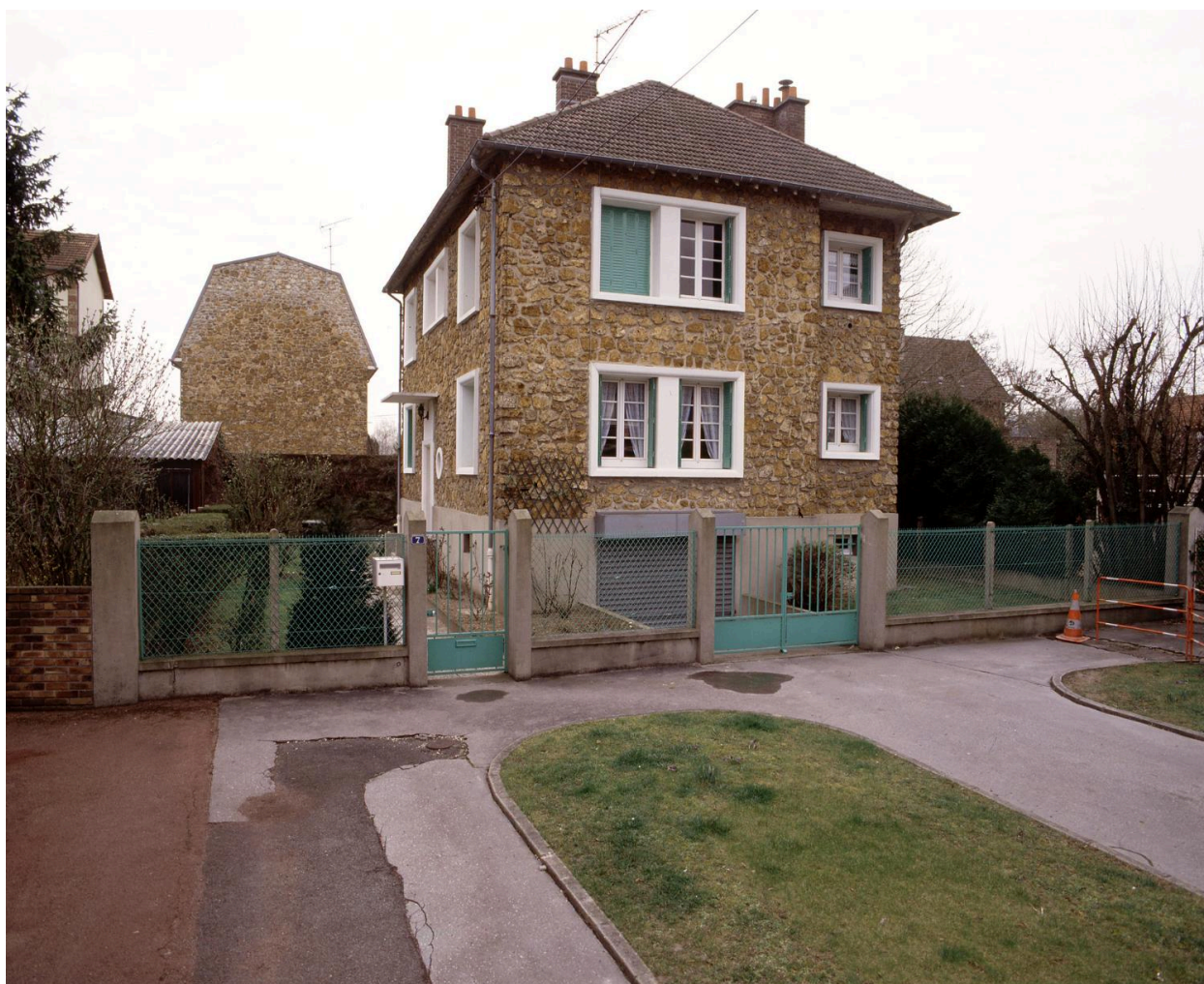
Vue d'ensemble de la maison reconstruite pour M. Bouchaudon au 7, rue Paul-Henri-Challine.
