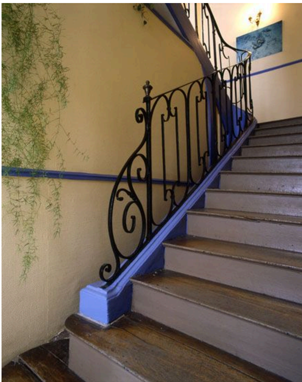
L'escalier : amortissement de la rampe et première volée.
