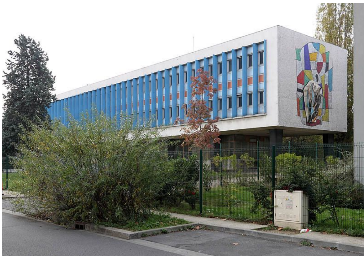
Alfortville, usine à gaz, quai d'Alfortville. Bâtiment administratif orné de la mosaïque de Fernand Léger. Photographie, 2011.
