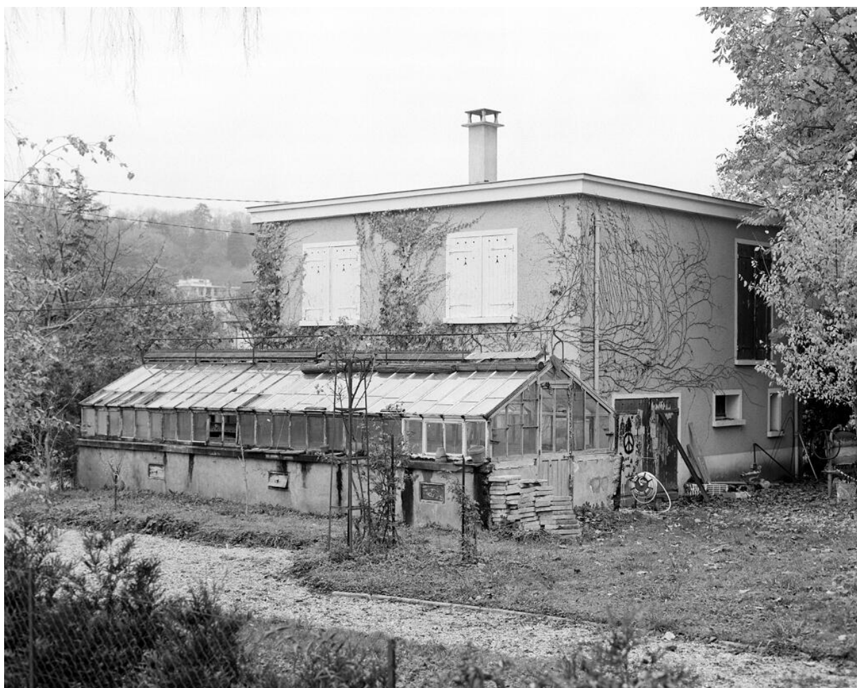
Maison de jardinier et vestiges de la serre.
