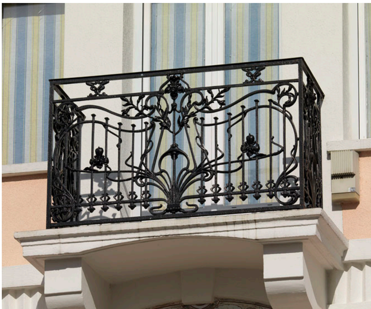
Fonte et ferronnerie : détail du garde-corps d'un balcon de style Art nouveau d'un immeuble, rue des Thermes.
