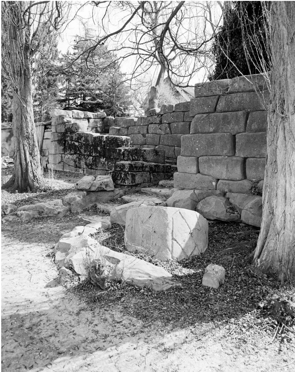
Vue du jardin du côté de l'embarcadère : des blocs en béton imitent un opus cyclopéen.
