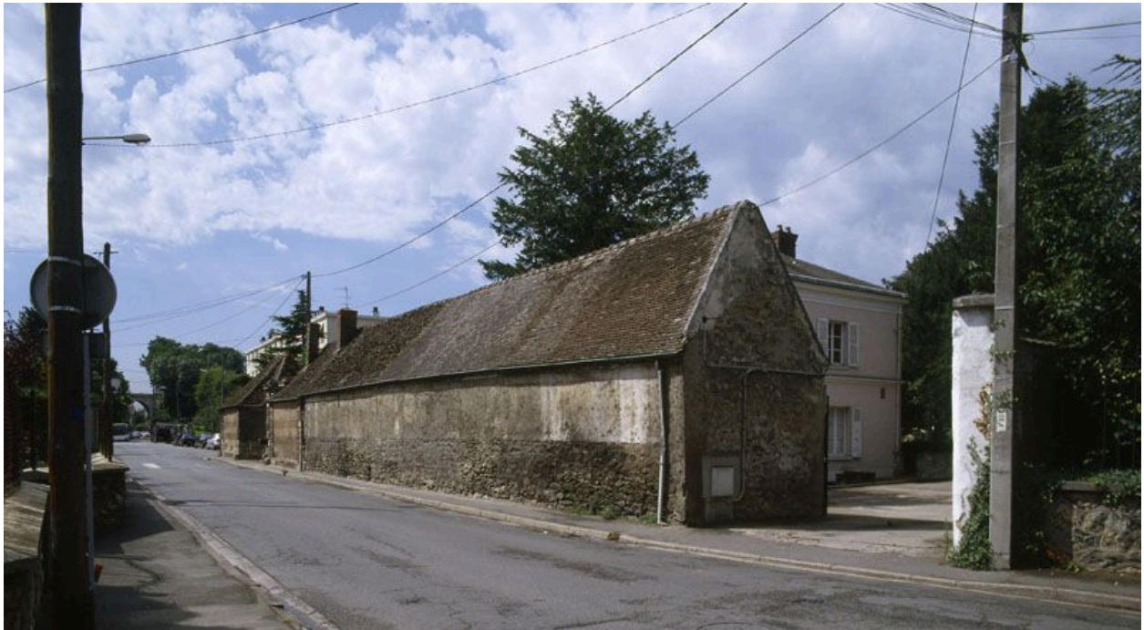
Façade sur rue des anciens communs.
