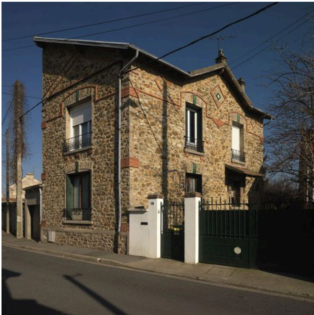
Vue d'ensemble de la maison perpendiculaire à la rue, 18 rue des Creuses.
