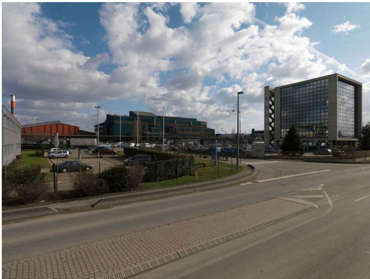
Porcheville ; Gargenville, aciérie Alpa, 25 avenue du Val. Au centre, les ateliers de fabrication. A droite, le bâtiment administratif d'entreprise.
