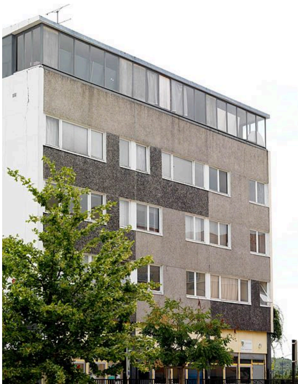
L'immeuble prototype. Détails des séchoirs en haut (actuellement vitrés).
