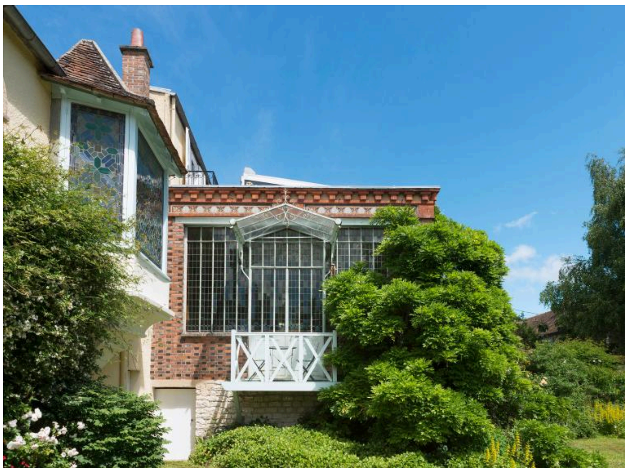
vue générale atelier de Césaire Detti puis de Paul Marguerite, 23 rue Delort
