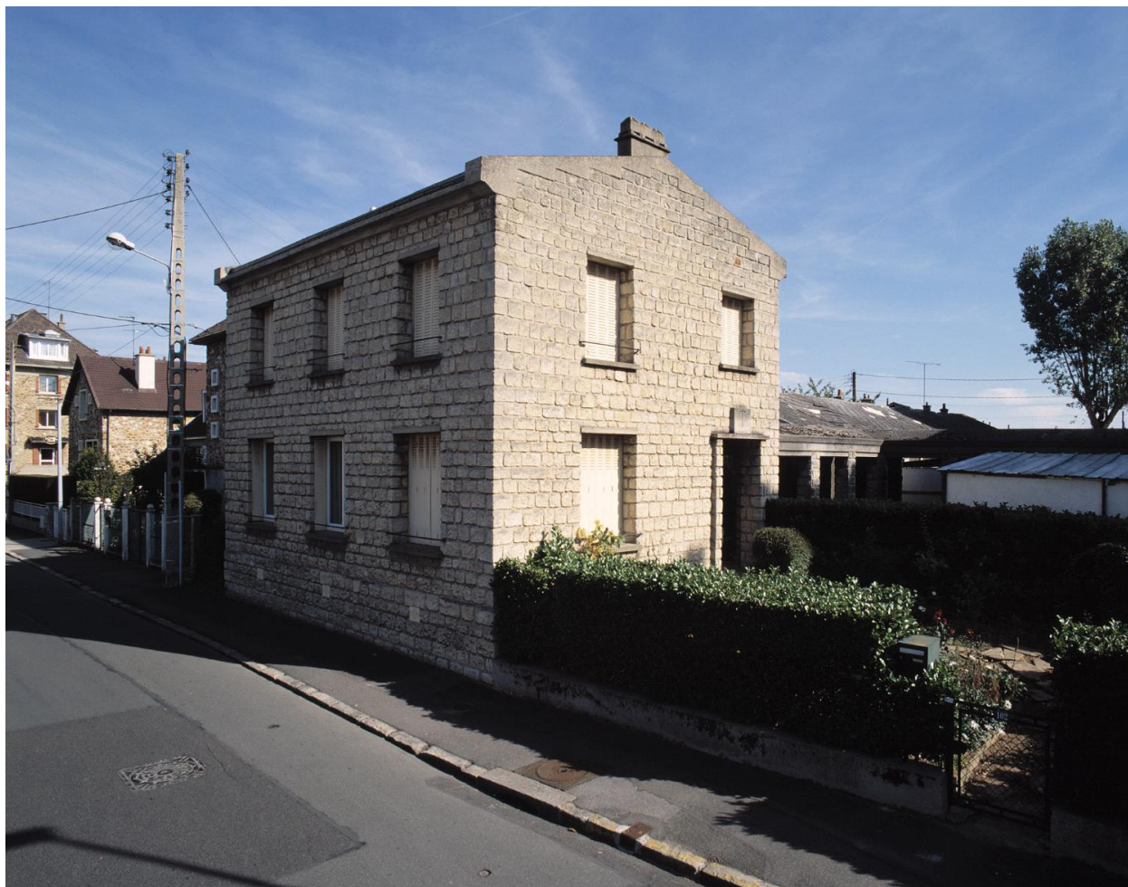
Vue d'ensemble du presbytère.
