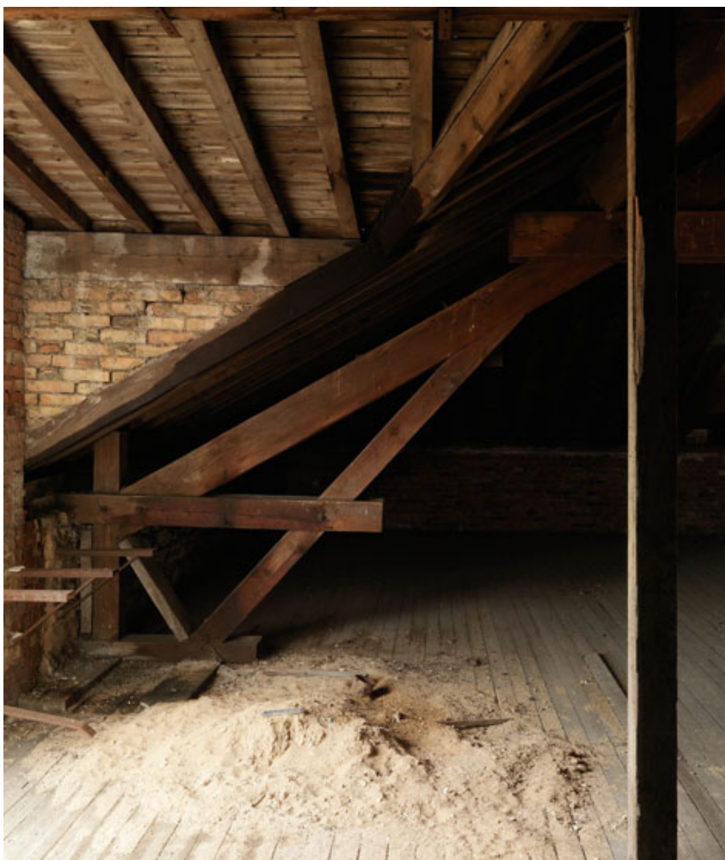
Vue intérieure. Combles.
