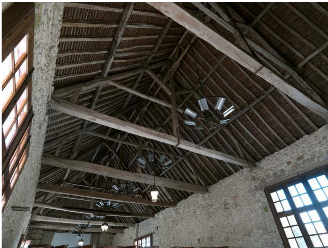
Vue sur la charpente de la grange ou des petites écuries.
