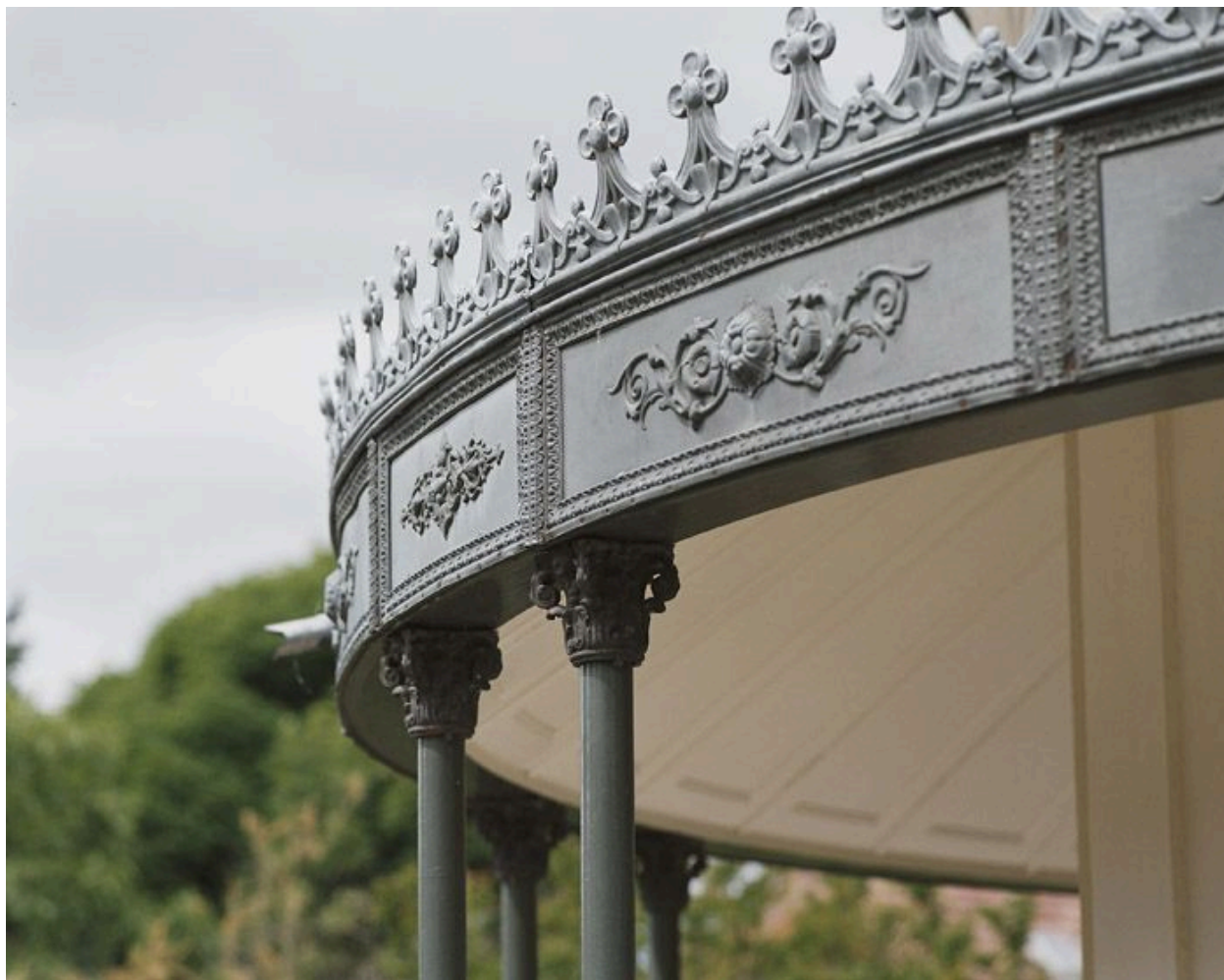
Autre détail de l'appentis et de son bandeau circulaire en zinc.
