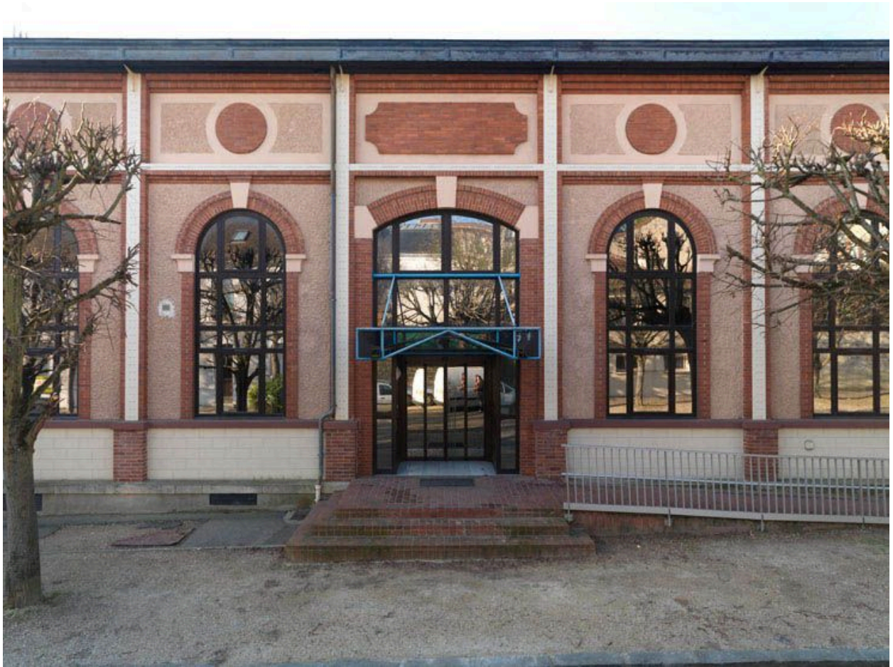
Entrée du bâtiment des machines de la centrale électrique, boulevard Orloff.
