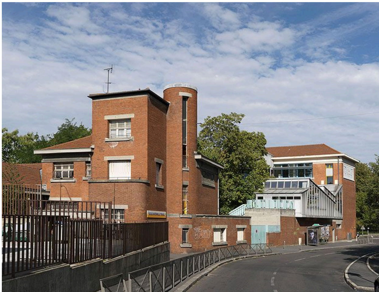
93, Bagnollet, collège Travail ,172-174 rue Sadi-Carnot. Vue des façades du logement de fonction.
