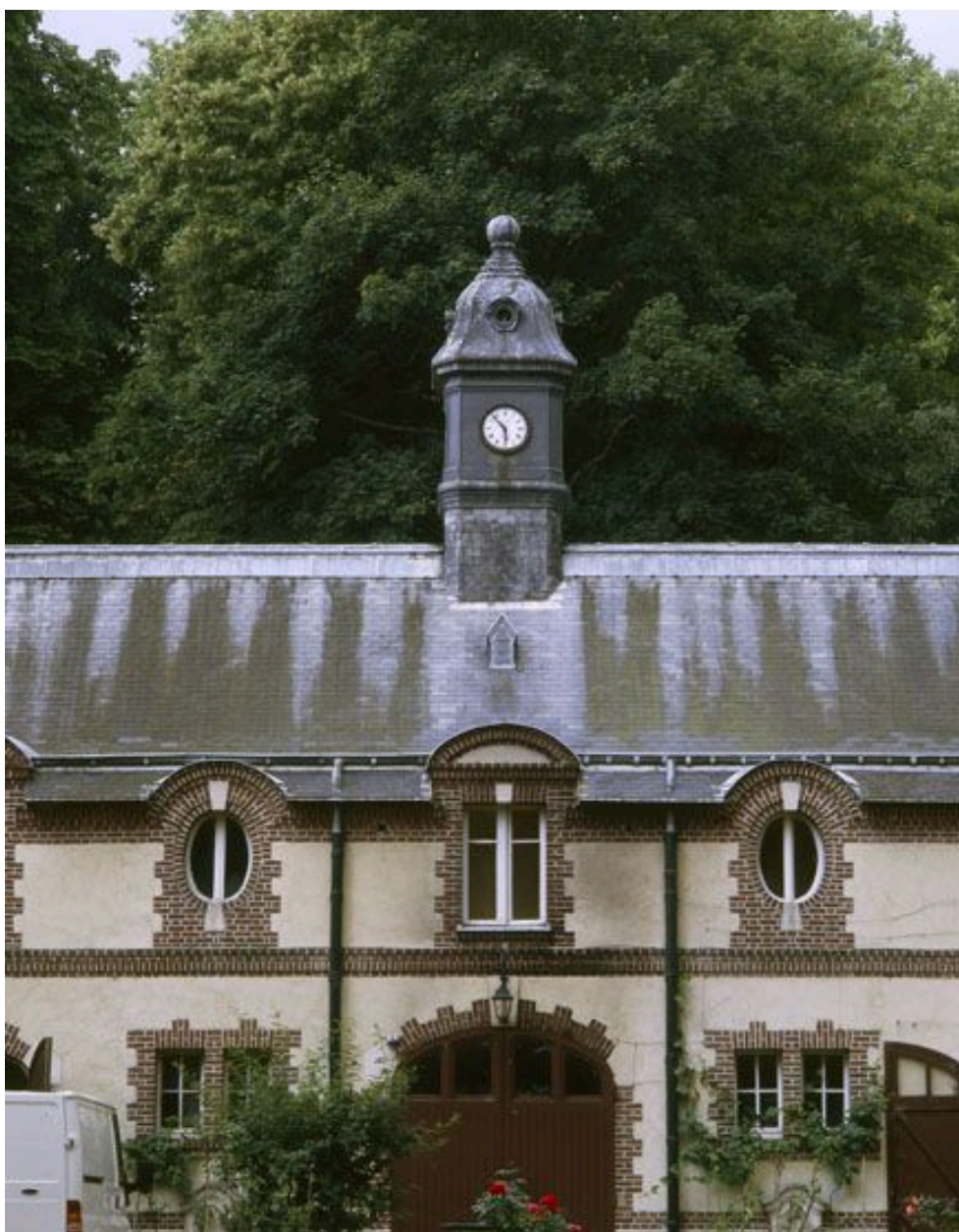
La travée centrale des communs.
