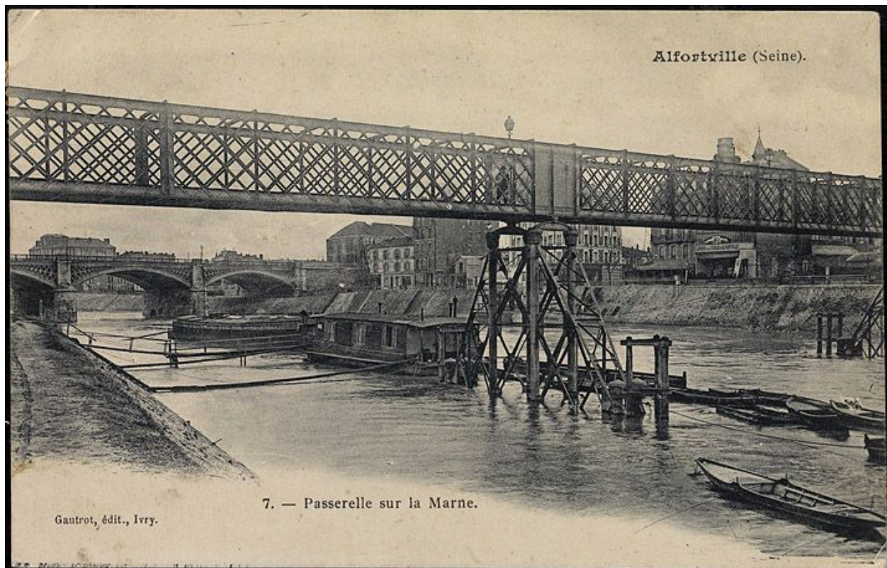
Alfortville. Vue d'ensemble de l'ancienne passerelle à la structure métallique similaire à celle de certains ponts de chemin de fer. Carte postale. ( Musée de la batellerie, Conflans-Sainte-Honorine)
