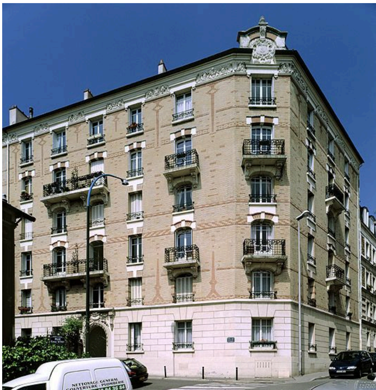
Immeuble, 11 rue de l'Abbé Guillaume. Vue d'ensemble.
