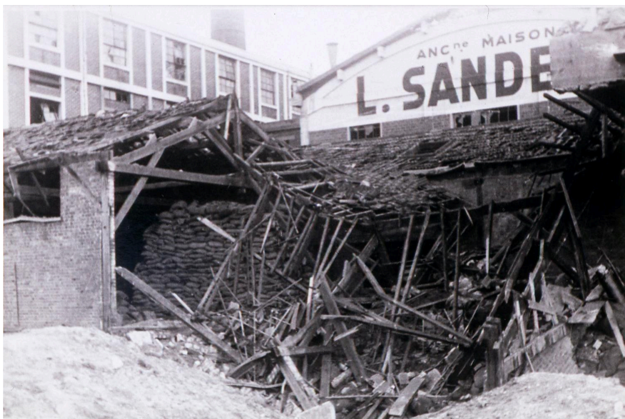
Les bâtiments atteints par les bombardements de juin 44.
