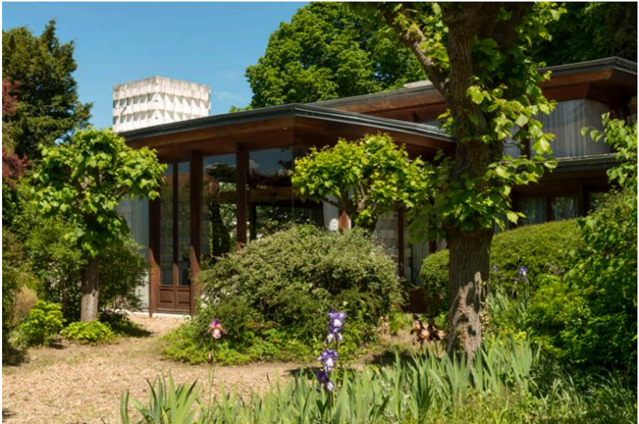
Vue générale de la Maison Weill et de la cheminée.
