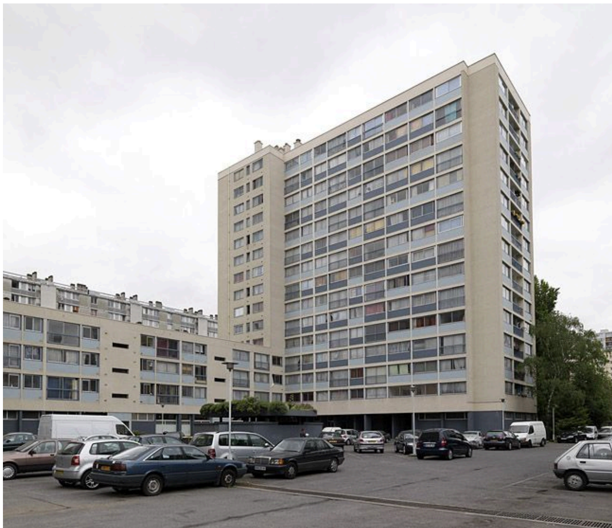
Vitry-sur-Seine, cité, 25-29 rue Camille-Blanc. Vue d'ensemble.
