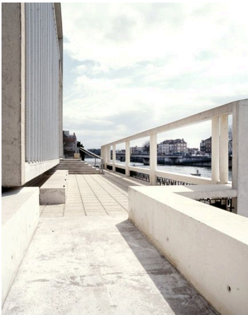
La terrasse vers la Seine, vue de l'ouest.
