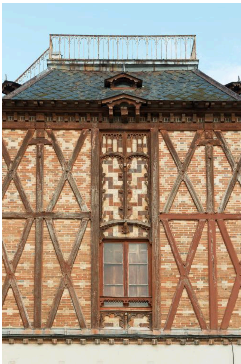
Vue rapprochée de la façade de l'atelier
