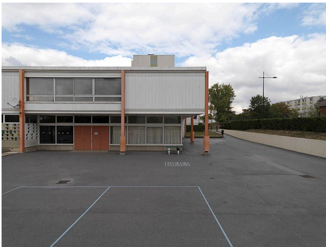
L'école primaire du groupe scolaire Alain : détail de la façade sur cour.
