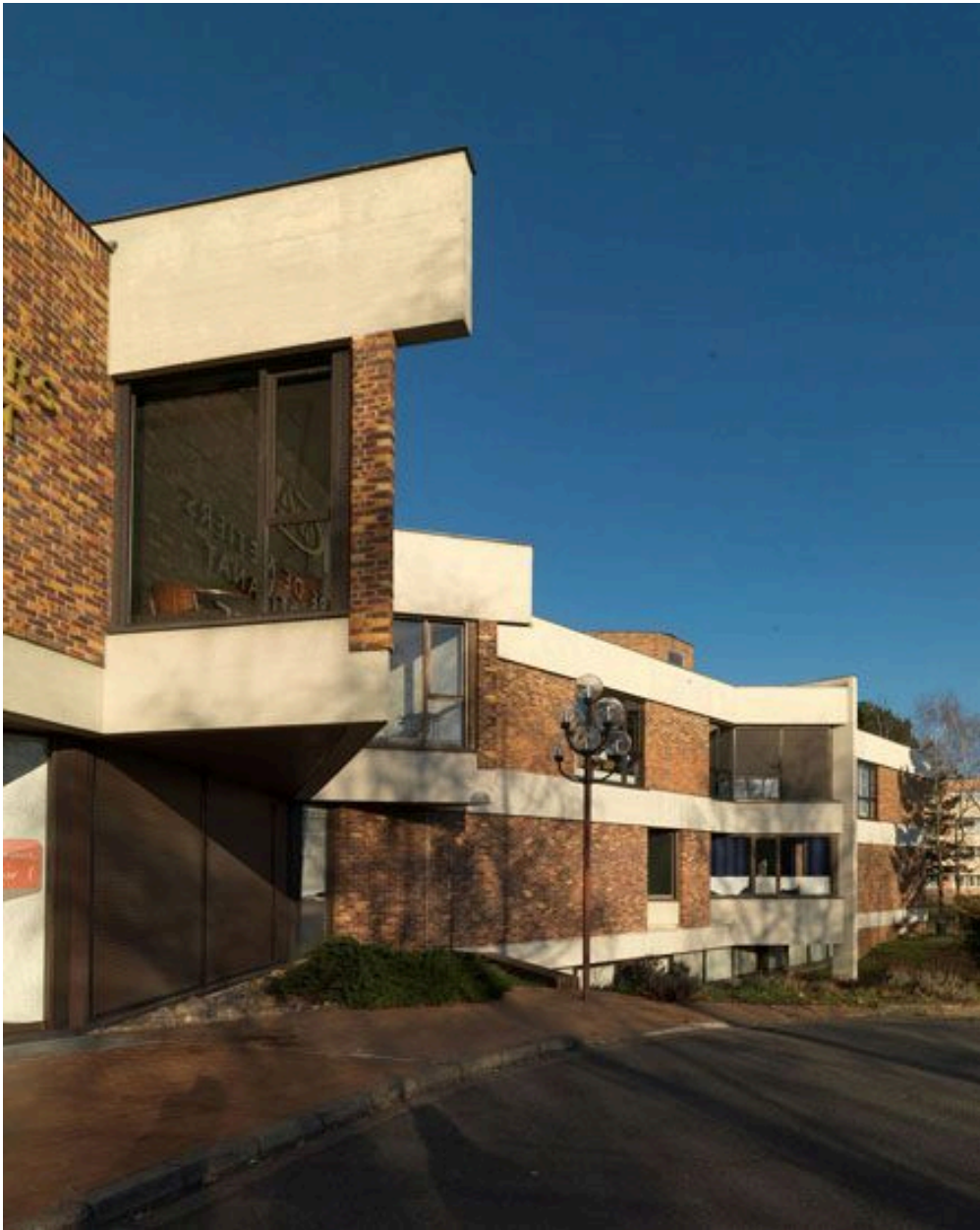
Détail architectural d'une façade : bow-window triangulaires.
