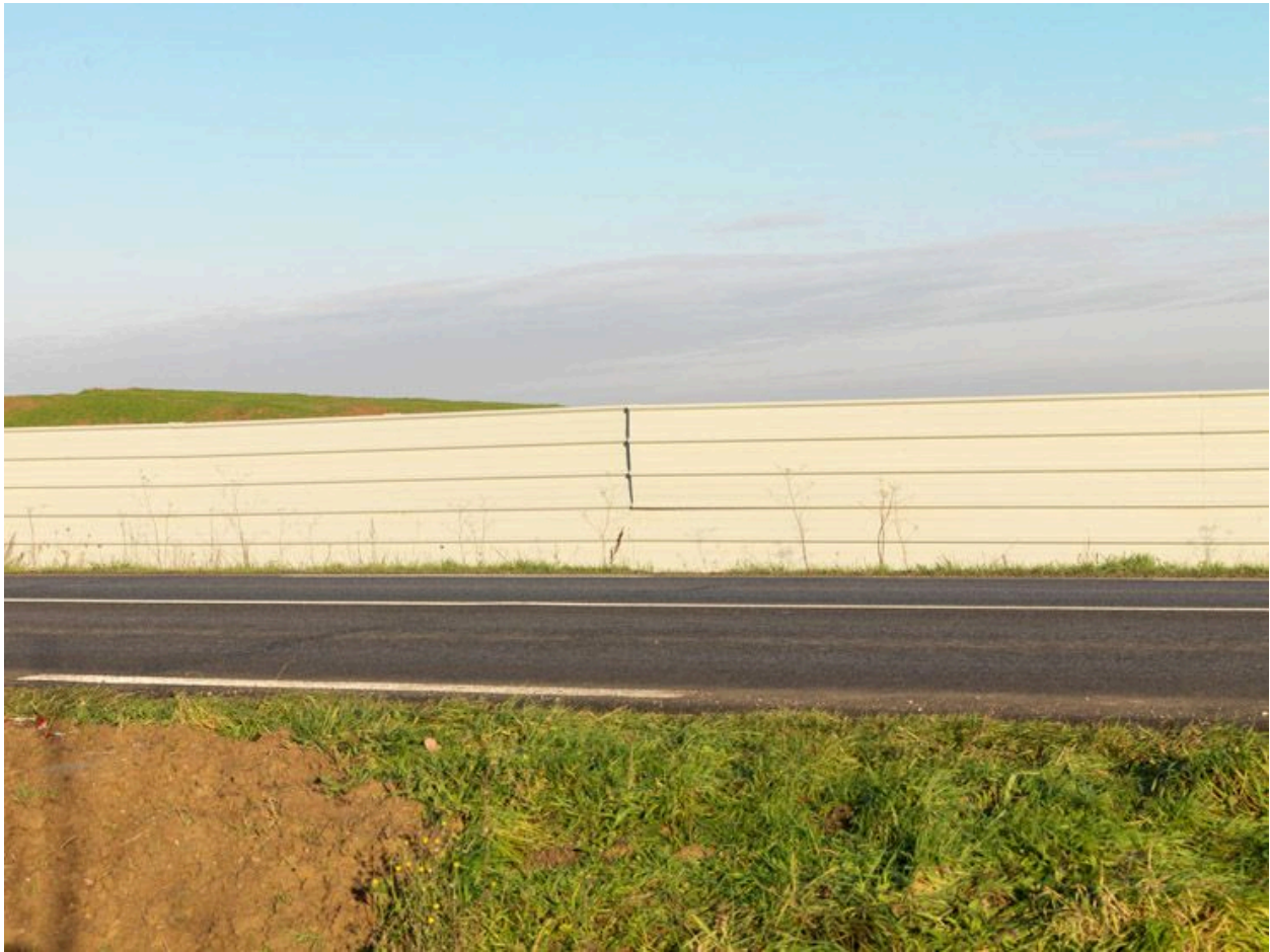
Orsay, route Départementale 118. Vue de la route départementale 128 avec en arrière plan les palissades du chantier Agro ParisTech.
