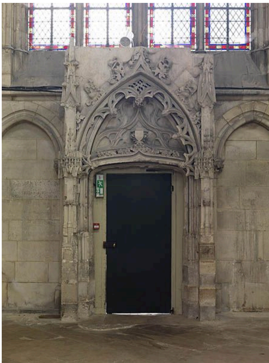
Vue d'ensemble, de face.
