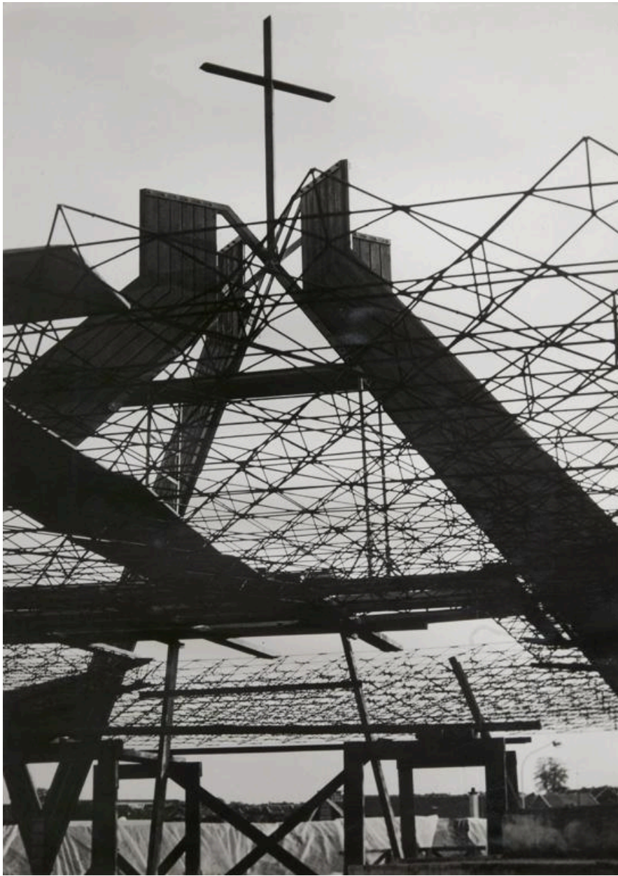
Montage de la charpente.
