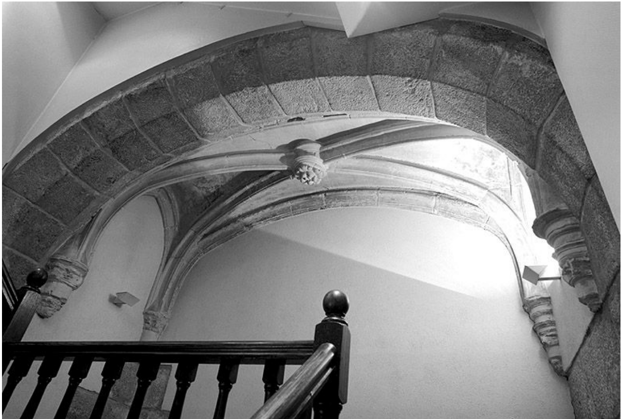
Arcade Renaissance, vestige de l'ancien hôtel-Dieu Saint-Jacques, en remploi au 4 rue Carnot. Vue d'ensemble, depuis l'escalier.
