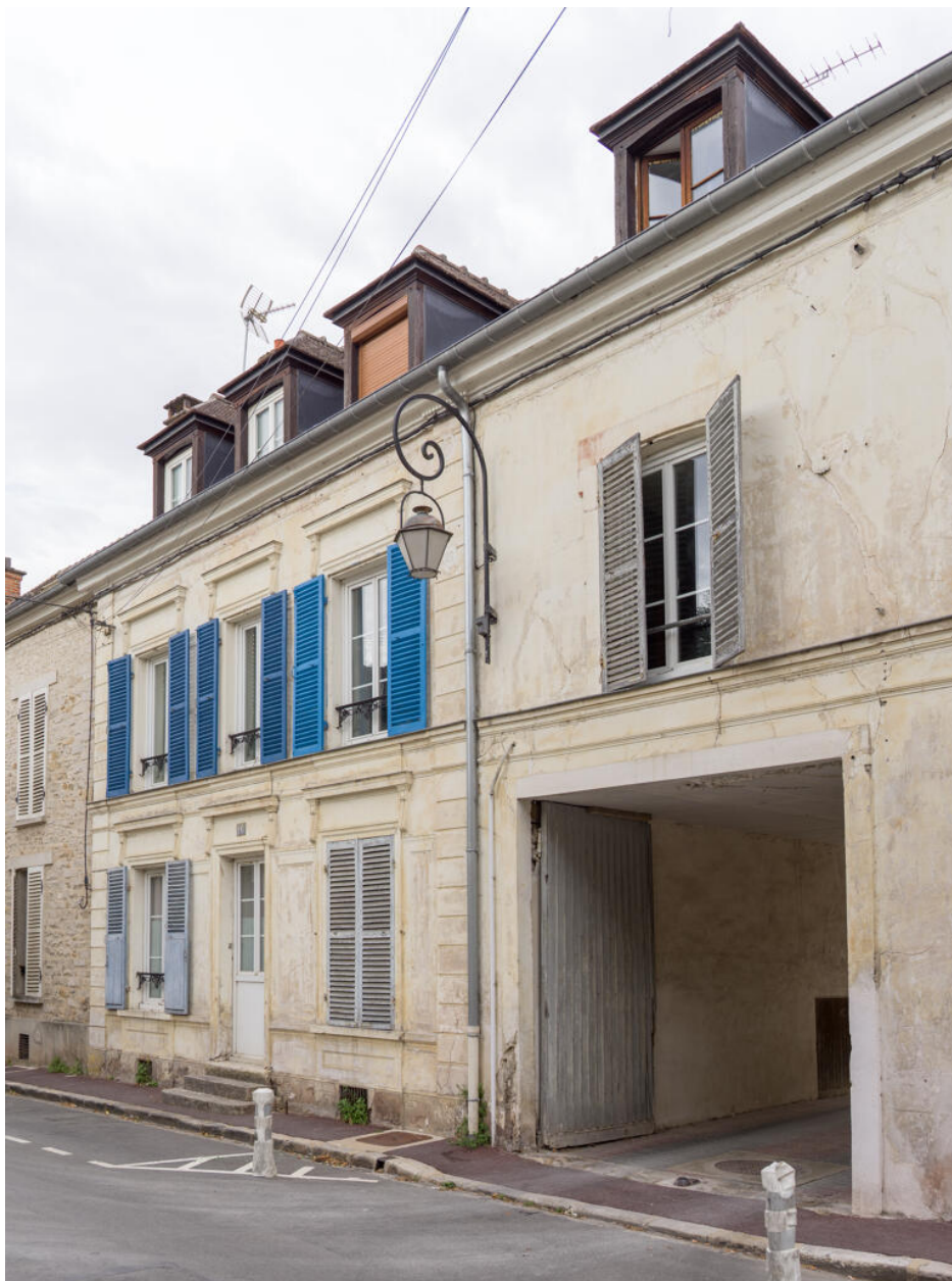
Vue générale de la partie sud de la façade rue la Farnault, depuis le nord-est.
