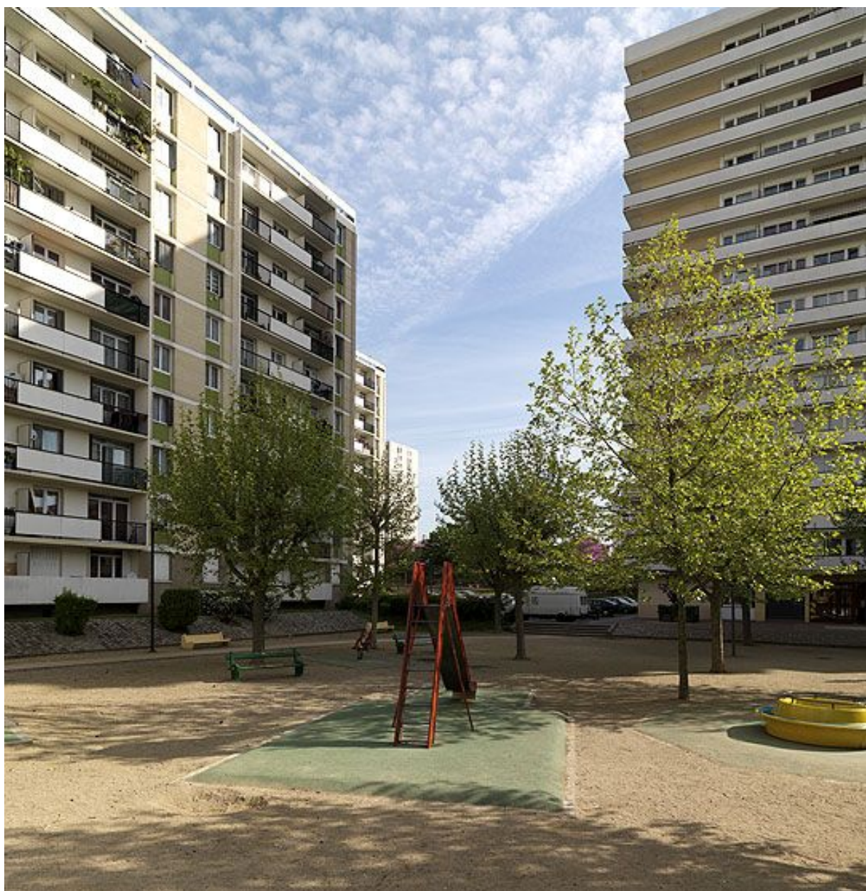
Vitry-sur-Seine, cité dite Cité Gagnée, rue Gagnée, rue Champollion, rue de la Fraternité. Vue du parc dans la cour intérieure.
