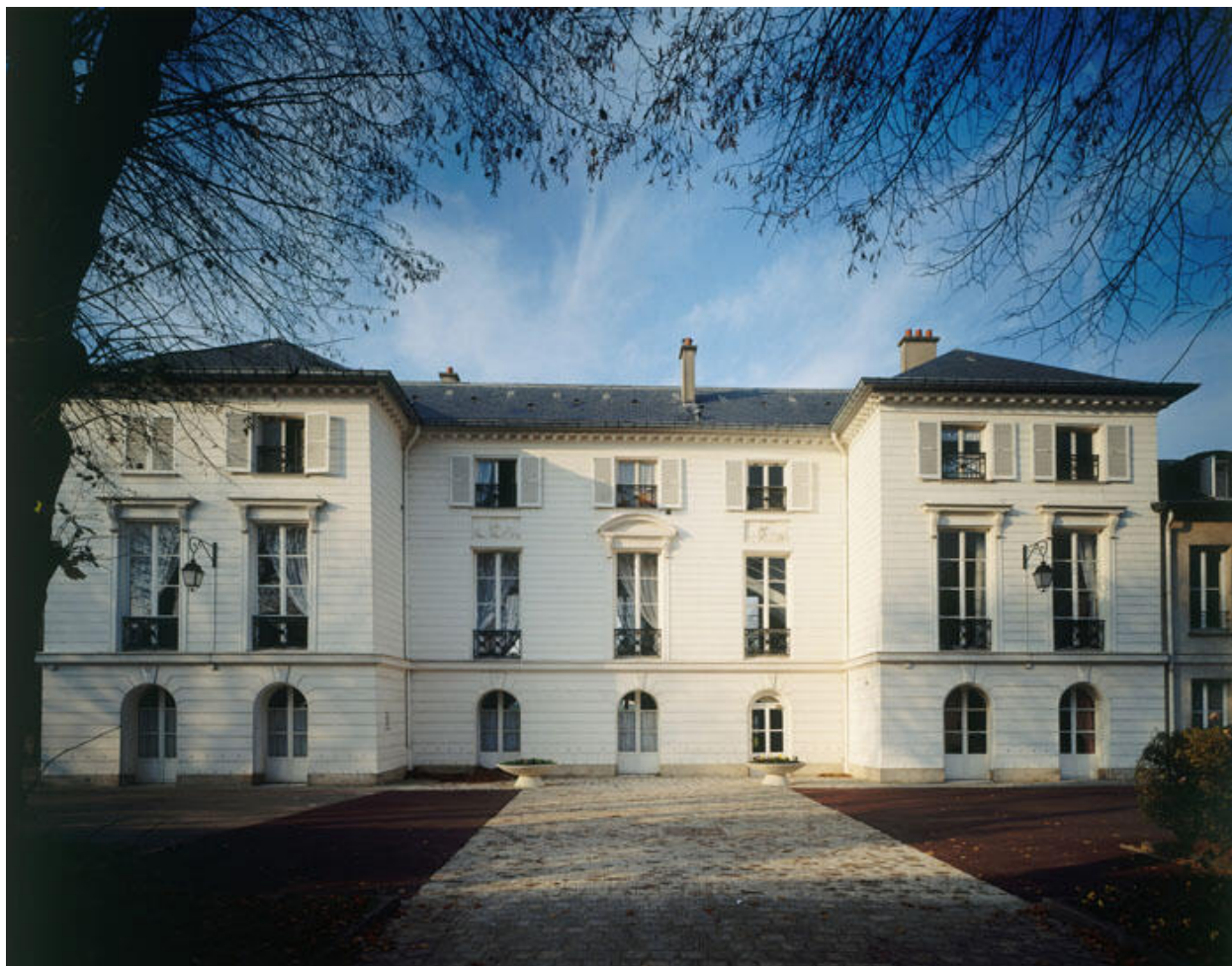
La façade antérieure, côté est, donnant sur la rue Voltaire.
