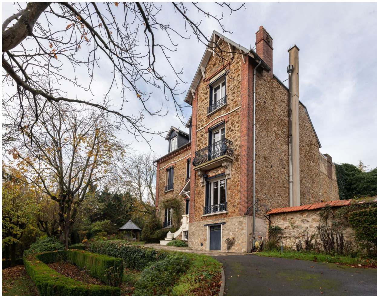
Villa les Rochettes, façade principale (sud) sur la vallée
