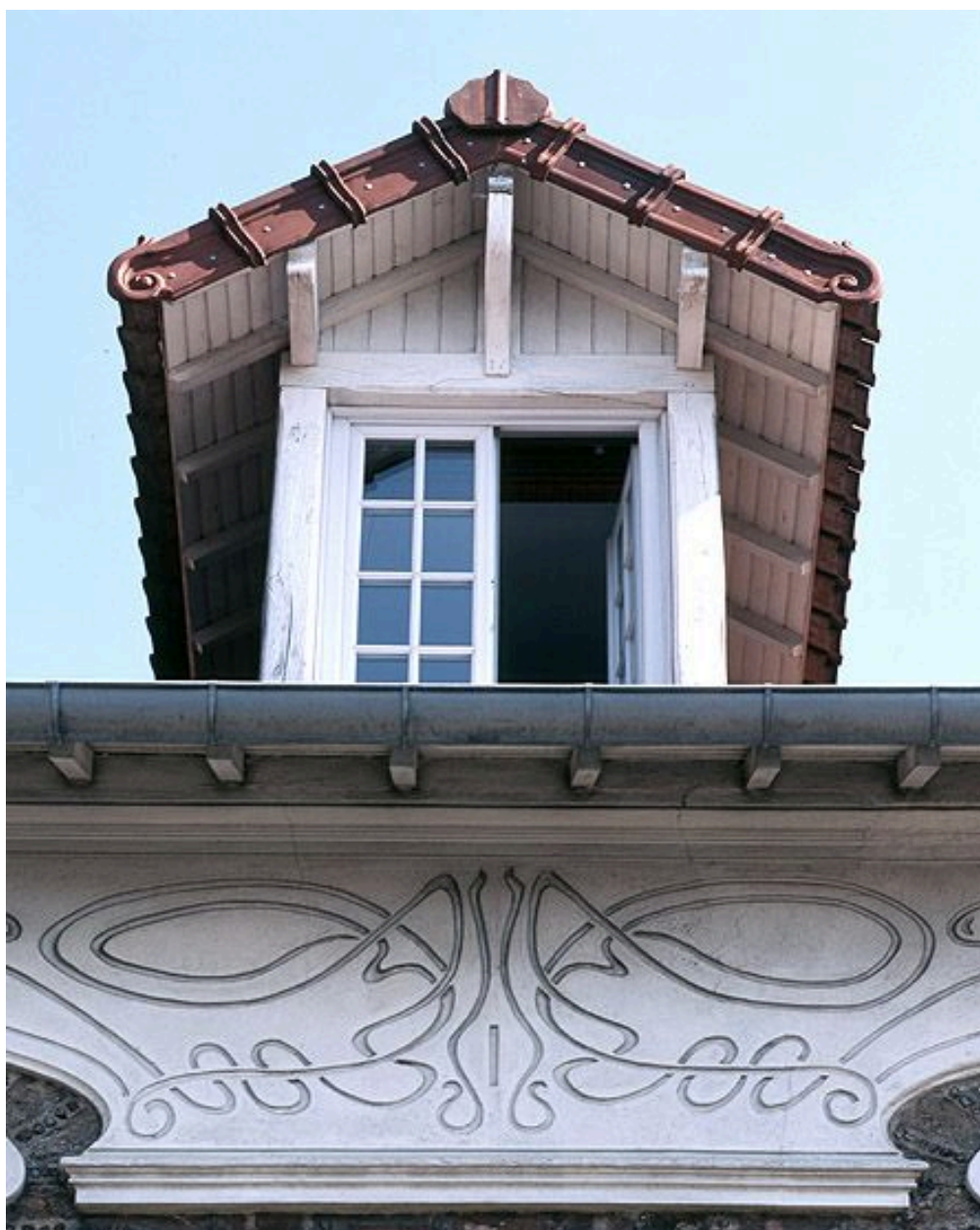
Détail de la lucarne sur la façade latérale.
